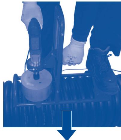
**DE** 1] X-Stream-Sattel ermöglichen einen wasserdichten und sicheren Anschluss von KG-Rohr DN 150 an X-Stream mit Nennweiten DN 250 bis DN 800. Überprüfen Sie beim Auspacken des Sattels, ob dieser unbeschädigt und sauber ist. Nennweite auf dem Sattel muss mit der liegenden X-Stream Leitung übereinstimmen.
