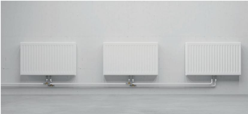
**Fig. 46:** Sistema di distribuzione a due tubi (standard)
