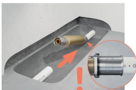
3. Assicurarsi che la superficie della tubazione sia perfettamente liscia e pulita. Posizionare una boccola del manicotto di riparazione su una delle estremità libere della tubazione. Attraverso la finestra di controllo verificare che la tubazione sia inserita correttamente. (IN4SURE™)
