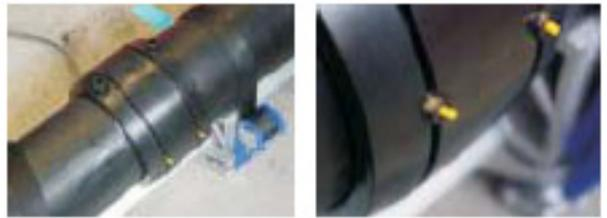
10. Contrôler le temps de soudage (ceci vous donne une indication en cas d'anomalie) et laisser refroidir l'ensemble avant de mettre en charge. Durée minimale de refroidissement avant d'enlever le positionneur ou d'exécuter un essai de pression: voir table ci-dessous.
