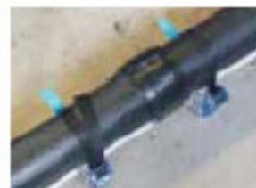
8. Respecter les instructions de la procédure de soudage. Pendant le soudage, on doit maintenir la température ambiante ainsi que celle des tuyaux et accessoires au de la de 0°C. Par forte chaleur, des précautions doivent être prises pour que les tuyaux ne dépassent pas la température de 30°C dans la zone de soudage.
