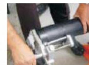
3. Préparer les extrémités des tubes et/ou des accessoires par **raclage** de la zone de soudage et les **nettoyer** avec un solvant.
