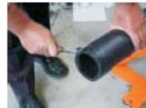
2. Il est nécessaire de couper les tubes perpendiculairement, de les ébavurer et d'enlever les saletés, éventuellement aussi à l'intérieur des tubes.
