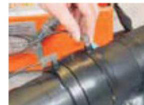
7. Bloquer l'ensemble ou placer un appareil de fixation. Pendant le soudage et le temps de refroidissement, aucune torsion, inclinaison ou mouvement axial ne peut se produire.
