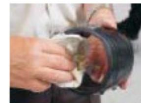
5. Marquer la profondeur de l'emboîtement du manchon électrosoudable sur les extrémités à raccorder. Ceci permet un assemblage visuellement contrôlable. Éviter de toucher la zone de soudage avec les mains. Voir également la mention au dos.
