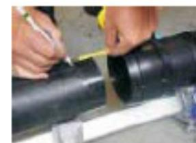
6. L'assemblage se fera impérativement sur des éléments propres et parfaitement secs. En cas de pluie, réaliser l'opération sous abri (bâche, parapluie). L'opération de soudage des manchons proprement dite se fera le jour même de leur placement, afin d'éviter la formation de condensation entre les surfaces à souder.
