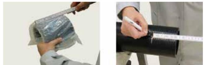
⦿ (H) Inserire il raccordo elettrosaldabile sull'estremità del primo tubo fino al segno di riscontro precedentemente marcato.
