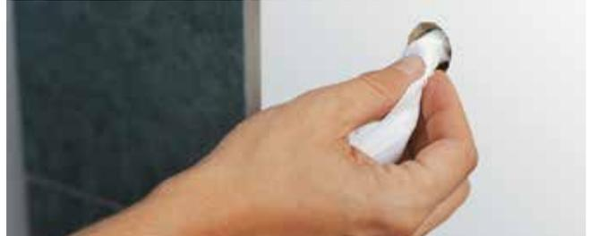
Pulire e asciugare la zona interessata dal foro. Misurare e segnare la profondità di inserimento sulla matrice in base allo spessore di parete del tubo forato+2mm e bloccare il fermo di battuta.
