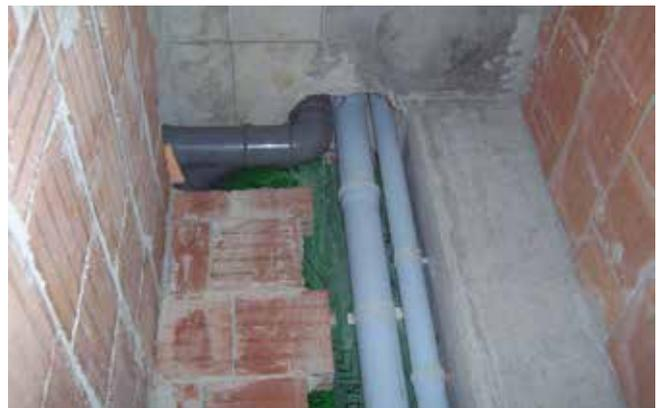
Negli attraversamenti isolare i punti di contatto per evitare la trasmissione di rumore.
