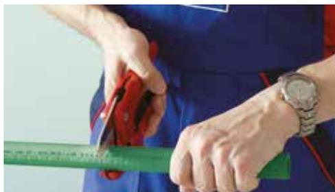
2- Per i diametri superiori a 40mm, si consiglia di smussare i bordi esterni delle estremità dei tubi, ciò eviterà che eccessivi riporti di materiale siano trasferiti all'estremità del raccordo, durante la fase di saldatura.
