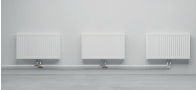
Fig. 47: Het klassieke verwarmingssysteem met 2 buizen.
