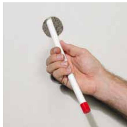
Fig. 30 Proteggere sempre le estremità del tubo.
