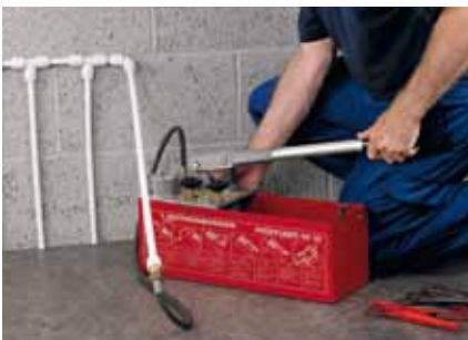
Fig. 80 Test di pressione.
