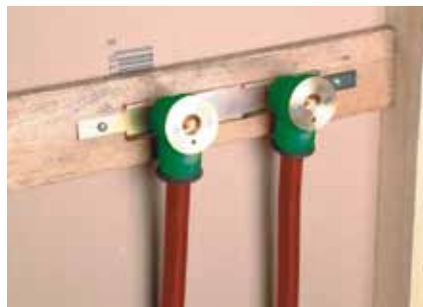
Fig. 65 Terminali Slider staffati.
