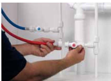
Fig. 36 Rubinetto di intercettazione AF557.
