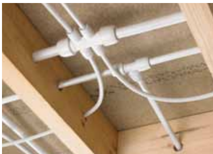
Fig. 40 Esempi di posa in strutture in legno.
