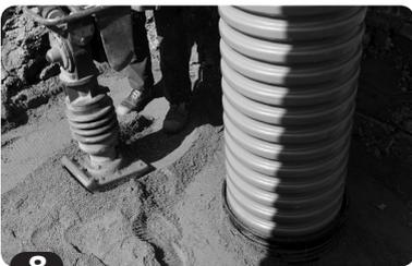
Der tilfyldes jævnt med friktionsmateriale rundt om brønden i lag (max. 30 cm), og der komprimeres løbende. Komprimering sker i henhold til de krav der stilles til konstruktionen over. I arealer med trafiklast komprimeres til min. 98% Standard Proctor. Der henvises i øvrigt til projektets beskrivelse af kote- og komprimeringsforhold mv.
