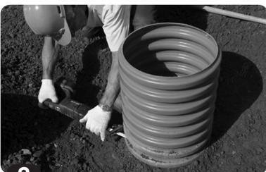
Opføringsrør afkortes i forhold til den færdige overflade og den valgte dækseløsning.
