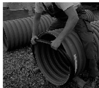
3. Gummiringen placeres i nederste korrugering.
