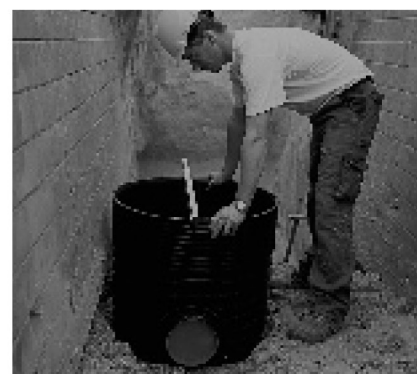
1. Brøndbunden placeres på et stenfrit udjævningslag. Der er ikke indbygget fald gennem brønden.
