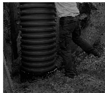
4. Opføringsrøret monteres i muffen på brønden.
