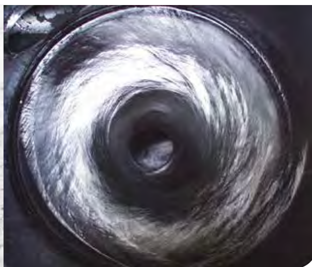
Charakter przepływu w studzience do wytracania energii
