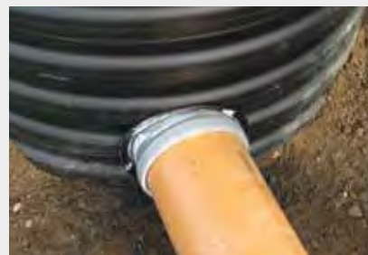
6. Tak zamontowana wkładka in situ gotowa jest do umieszczenia w niej rury kanalizacyjnej.
