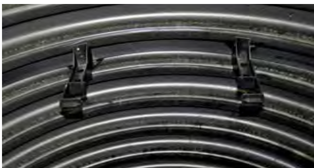
Rys. 5. Premontaż obejmy drabinki w rurze trzonowej
