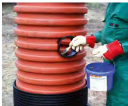
2. Następnie oczyszcza się krawędzie otworu z zadziorów.
