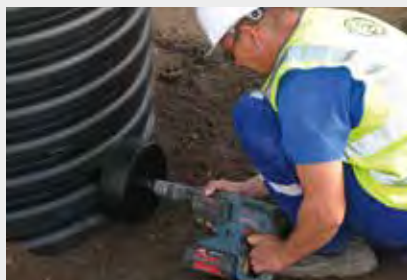
2. Następnie oczyszcza się krawędzie otworu z zadziorów.
