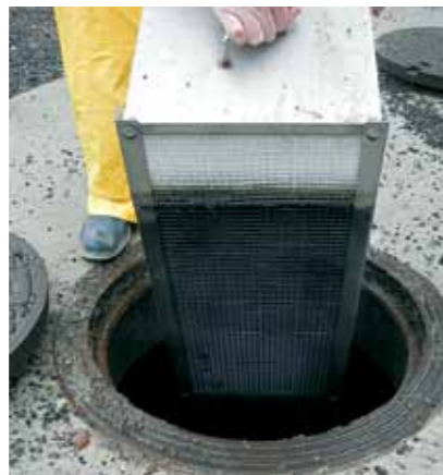
Koalescencinį bloką galima ištraukti techninės priežiūros darbams atlikti.
