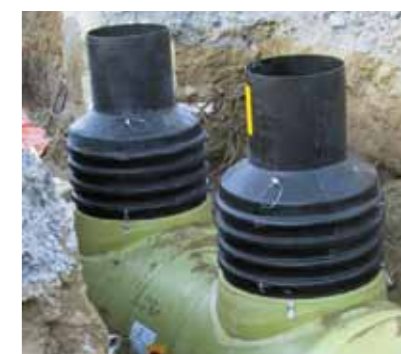
Sumontuoti EuroHUK techninio aptarnavimo šuliniai.
