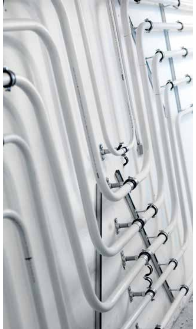
Şekil 1: Ek parça kullanılmadan oluşturulan güvenilir tesisat
