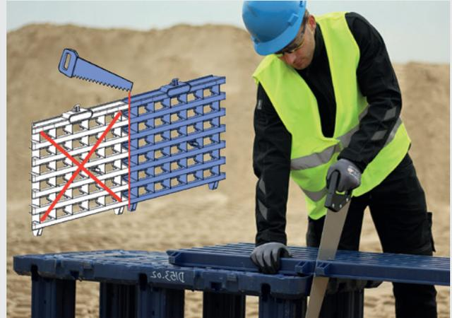
**Remarque 2 :** après la découpe, il existe une version droite et une version gauche. Assurez-vous que le côté arrondi de la moitié de plaque est positionné à l'angle du système (et non le côté découpé !).
