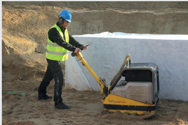
Le degré de compactage doit correspondre à celui du sol existant et être adapté aux conditions de l'eau et des futures charges externes.
