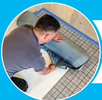
Die Montage der Wavin Klett Rollbahn „Standard“ erfolgt überlappt. Die Release-Folie wird einfach unter der Rolle herausgezogen. So kann die selbstklebende Rollbahn auf dem Boden fixiert werden.
