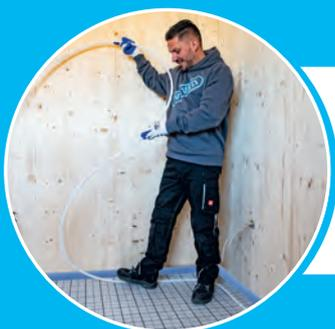
Nun kann das mit Klettband ummantelte PE-RT Rohr oder Verbundrohr einfach durch Andrücken mit dem Fuß in „Ein-Mann-Verlegung“ an der Rollbahn fixiert werden.
