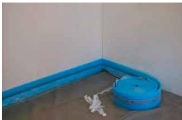
Abb.: Verlegung Randdämmstreifen
