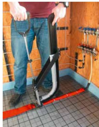
Abb.: Befestigung von Isolierstreifen bei durchlaufenden Zuleitungen
