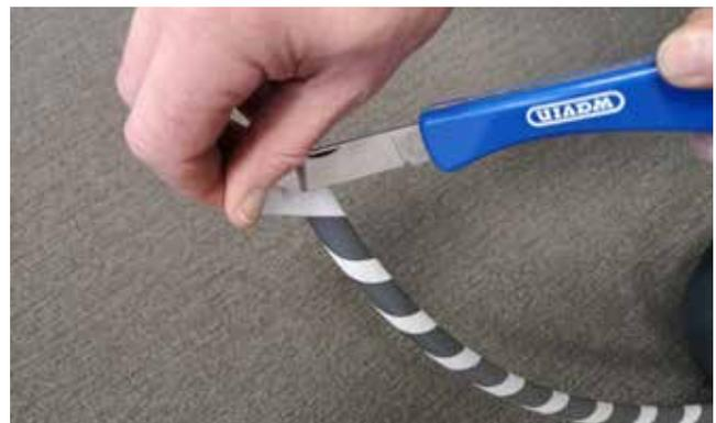
Das Rohr für den Anschluss am Verteiler in der Länge grob abschneiden, an den Verteilerbalken anhalten und das Maß Unterkante Anschluss Eurokonus markieren.
