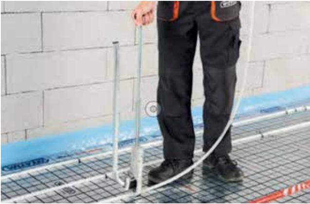
Abb.: Rohrverlegung mit Tackernadeln/Tackerwerkzeug
