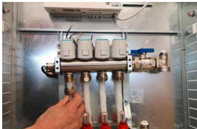
**Achtung:** Der Übergang auf Eurokonus muss bis zum Anschlag in das Heizrohr eingeführt werden. Je nach Heizrohr kann hierfür eine erhöhte Kraftanstrengung benötigt werden. Ein Einschlagen des Übergangs beschädigt die Abdichtfläche und hat zu unterbleiben.
