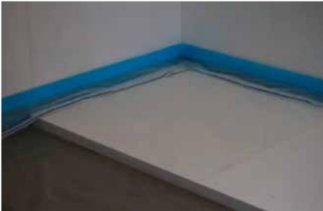
Abb.: Verlegung Zusatzdämmung
