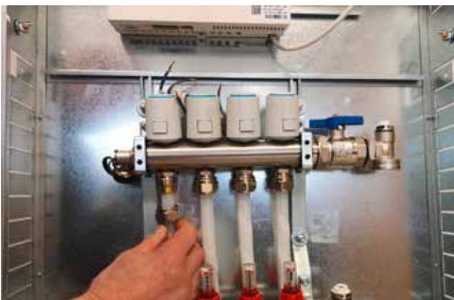
Abb.: Rohr an Verteiler
