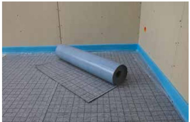
Abb.: Klettrolle und Randdämmstreifen
