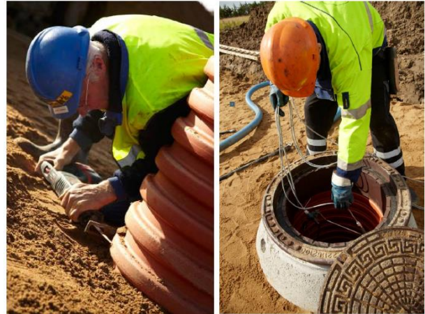
Katkaise Tegra 600 nousuputki oikeaan korkoon ja asenna hälytin ja kansisto kohteen käyttövaatimusten mukaisesti.
