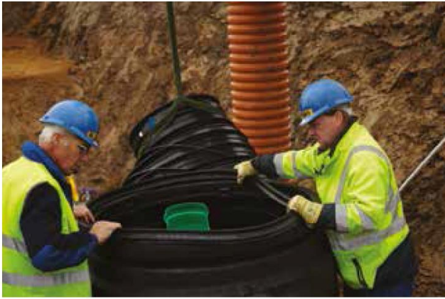
Laita Tegra 1000 tiiviste erottimen rungossa olevaan uraan.
