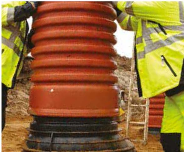
Paina Tegra 600 nousuputki paikalleen.
