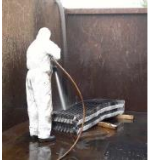
Pese koalisaattorit tarkoitukseen soveltuvassa paikassa, josta pesuvedet voidaan johtaa jatkokäsittelyyn.
