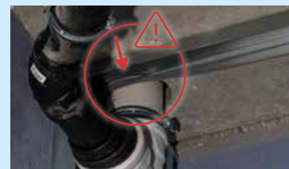
Kuva 41: Kosketuksen välttäminen profileihin
