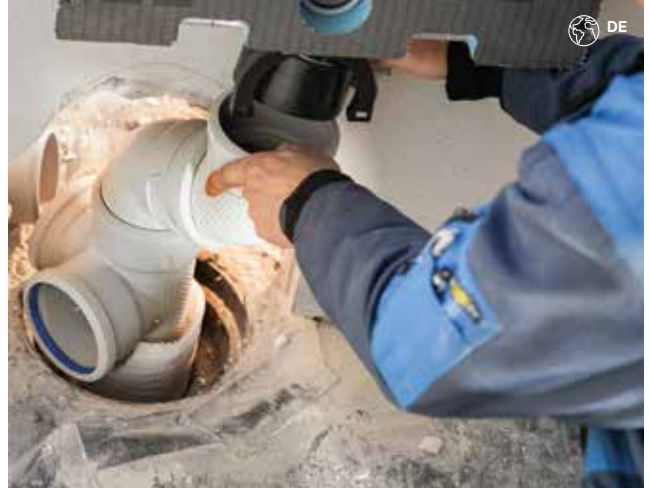
Kuva 42: Viemärin asentaminen betoniseen välipohjaan
