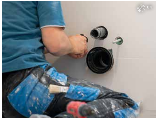
Kuva 43: Asennuksia laatoitetussa seinässä
