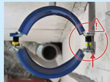
Kuva 40: Putkikannakkeiden oikea kohdistaminen
