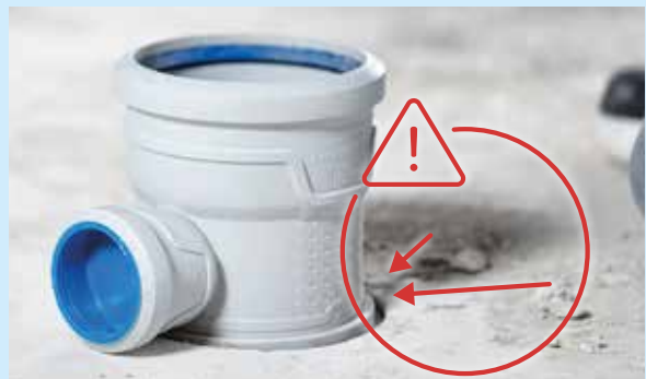
Kuva 21: Rakennusjäte runkoäänisillan aiheuttajana
