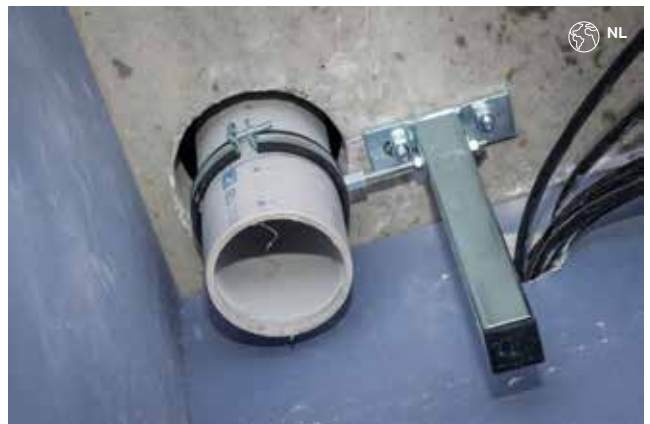
Kuva 11: Kannakointi massiivisiin rakenteisiin
