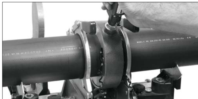
Srovnání konců potrubí integrovaným hoblíkem
