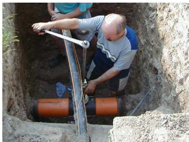
Vysazení přípojky pomocí sedlové tvarovky
