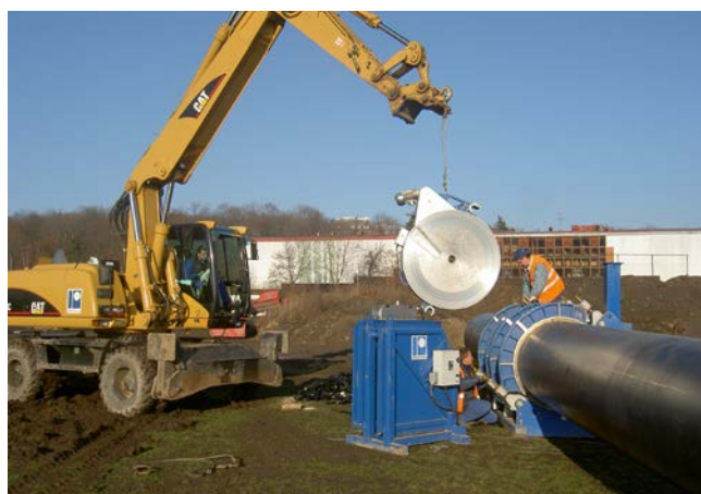
Sanace ocelového vodovodního přivaděče DN 800 v Chrudimi technologií Close-Fit (na stavbě)
