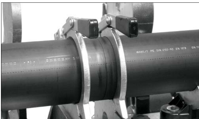
Správně připravené potrubí ke svařování
