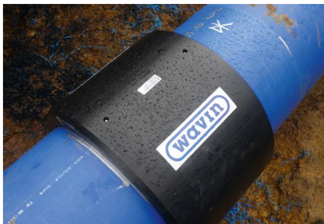
Spoj elektrospojkou d355 mm ze stavby v Dobřanech
