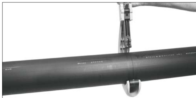
Řez potrubí ruční rotační řezačkou
