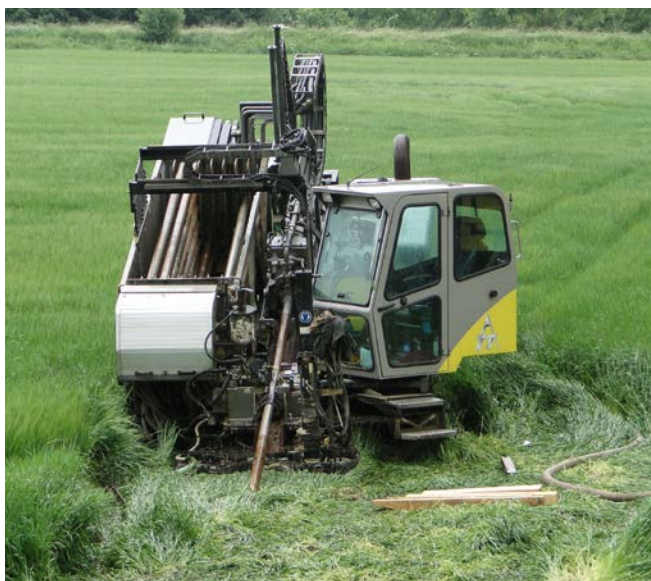
Pokládka vodovodního potrubí SafeTech RC d225 pro společnost Kofola a.s. v Krnově
