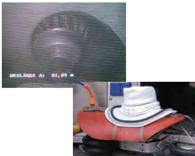
Rysunek 28 a, b Otwarcie światła przykanalika, kształtka kapeluszowa przygotowana do zainstalowania
