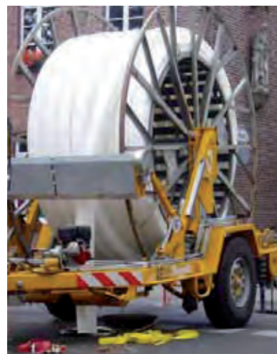
Rysunek 23 Umiejscowienie bębna nad studnią
