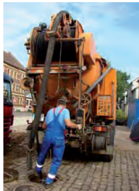
Rysunek 35 Metoda czyszczenia hydrodynamicznego
