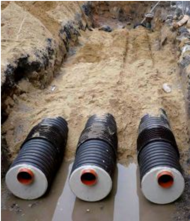
Sonderanwendung als Regenwasserstauraumkanal
