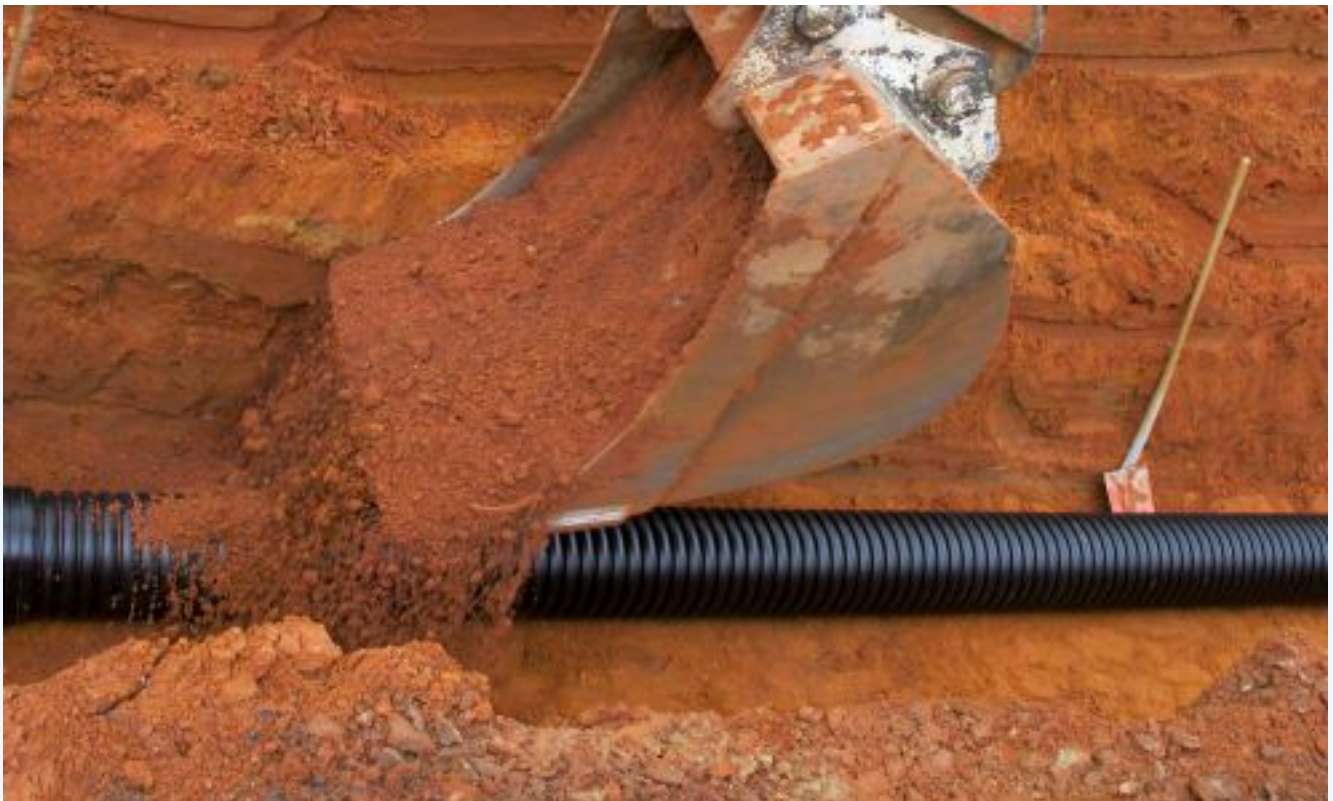
Einfache Lagesicherung durch Sandkegelaufschüttung
