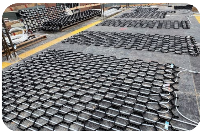
Registrové panely Wavin Comfia CW-90 položených na bednění desek
