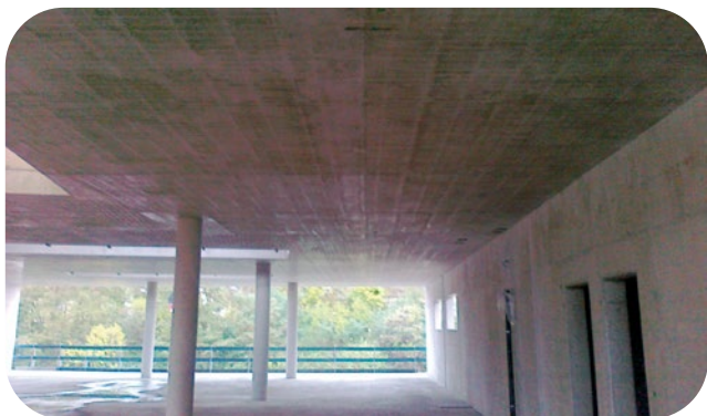
Hotová stropní deska
