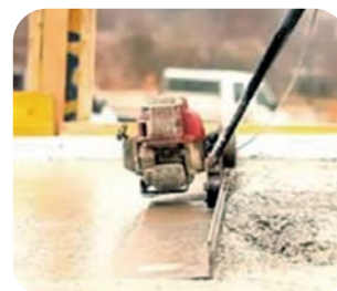
Bednění lité betonové desky a její hutnění po betonáži
