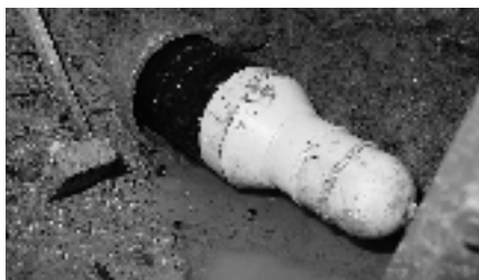
Pav. 16.2. Sudūrimo būdu suvirintas kūginis antgalis
