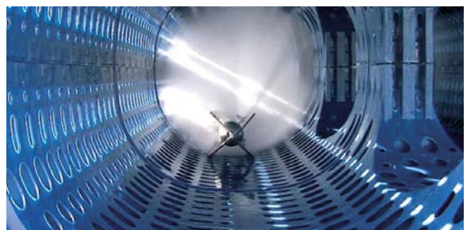
Tlakové čištění revizního kanálu v systému Q-Bic
