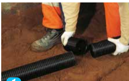
1 Anvend en dobbeltmuffe ved samling af to drænrør.
