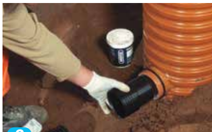
2 Tilslut overgangen fra glat- til drænrør i muffen.
