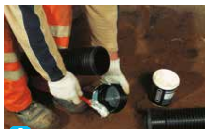
3 Anvend en slutmuffe, hvor røret ender blindt.
