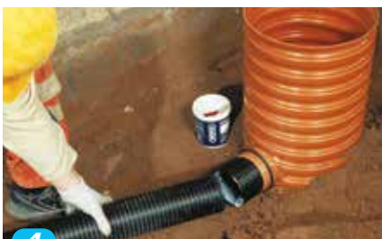
4 Montér drænrøret direkte i overgangen.
