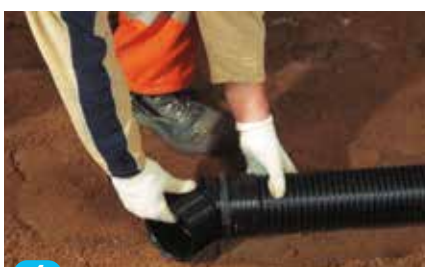
1 Montér bøjninger direkte i muffen på drænrøret.
