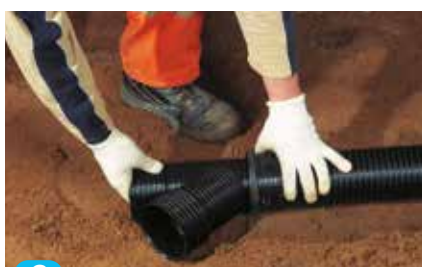
2 Montér grenrøret direkte i muffen på drænrøret.
