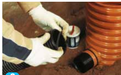
3 Sæt gummiringen fast på drænrøret i første spor.
