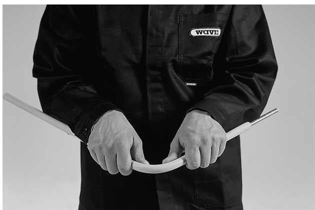
Afb. 3: Buigen van Wavin PE-X/Al buis zonder en met buigveer.
