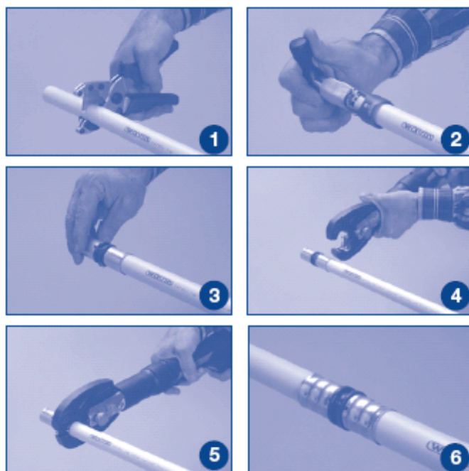
Fig. 1: Procedure montage "Tigris M1" en "Tigris K1"
