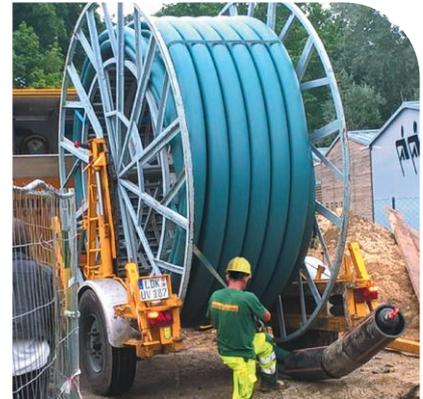
Wolfsburg, Allerpark/VFL Stadion, Abwasser-Druckrohrleitung, DN300, SDR 17, Alternative Verlegung, Diring & Scheidel
