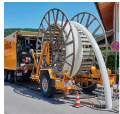
l'Allemagne, Hausham, eaux usées, DN300, SDR26, Max Bögl
