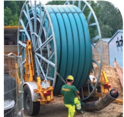
l'Allemagne, Wolfsburg, eaux usées, DN300, SDR17, Diringer & Scheidel
