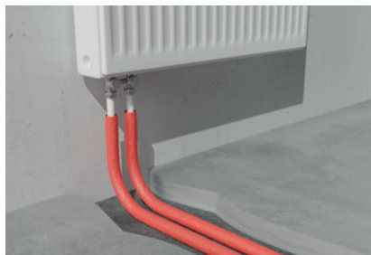
Afb. 47: Leidingaansluitingen uit de wand door middel van schoefaansluitingen binnendraad 'EURO-conus'
