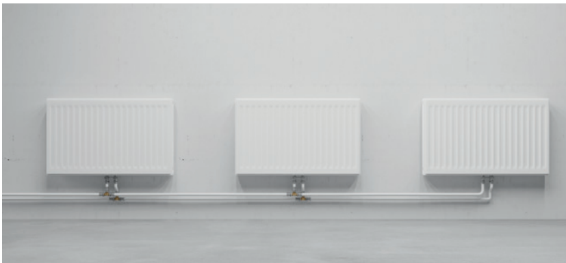
Afb. 46: Het klassieke verwarmingssysteem met 2 buizen.
