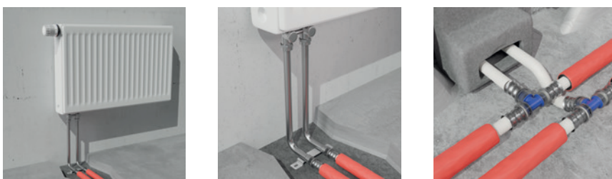
Afb. 49: Voorbeelden radiator aansluitingen met radiatorbochten.
