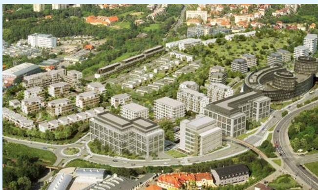
Rezidence Valtrovka, bytové domy, Praha
