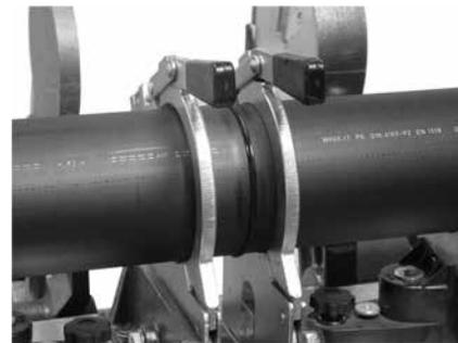
**13. Applicare lentamente la forza di saldatura e mantenerla per il tempo di raffreddamento necessario secondo i valori riportati nella tabella seguente.**
