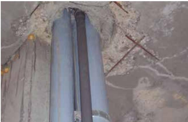
Evitare il contatto diretto con il cemento e dove non è possibile, frapporre materiale fonoassorbente (polipropilene espanso o lana di roccia).
