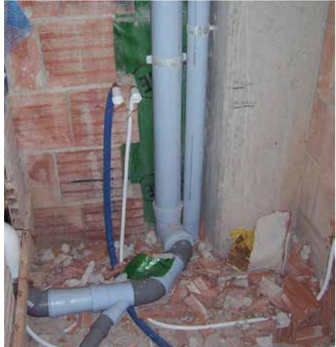
Evitare di mischiare sistemi differenti per non ridurre le prestazioni antirumore. Molti sistemi di scarico hanno diametri compatibili ma non le stesse caratteristiche di fonoassorbenza.
