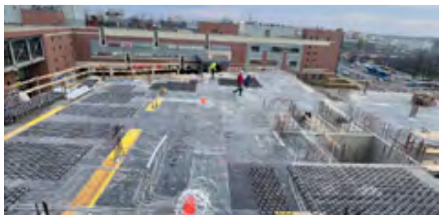
Betonkirekesztők a bekötővezetékekkel védőcsőben vezetett fűtőcsővel
