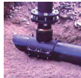
Rysunek 12 Połączenie za pomocą kształtki kołnierzowej
