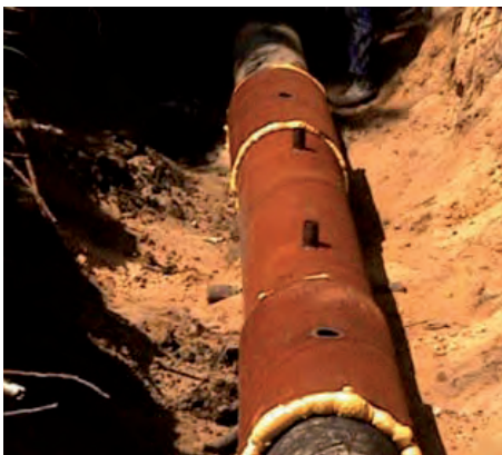
Rysunek 14 Przykład renowacji interaktywnej wykładziną Compact Pipe
