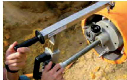
Rysunek 11 Sposób użycia zdzieraka mechanicznego
