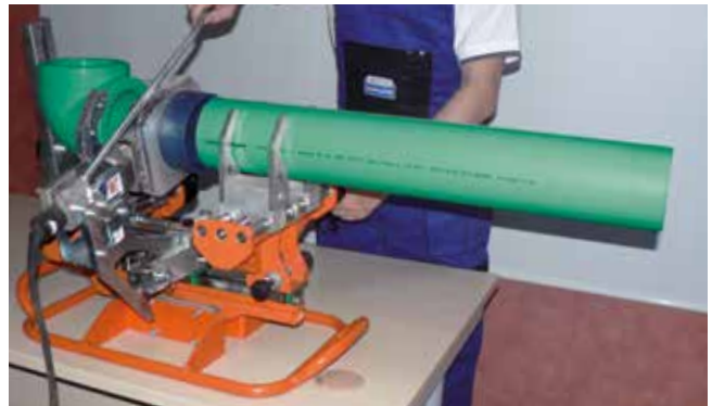
Fissaggio e allineamento dei componenti tra le ganasce della saldatrice e successiva fase di riscaldamento
