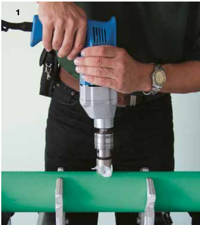
1 Marcare sulla tubazione il punto in cui creare la diramazione e forare con apposita fresa.
