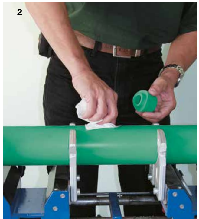
2 Pulire con apposito detergente per PPR e l'uso di un panno carta l'area interessata dalla saldatura ed asciugare.
