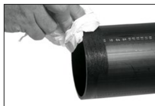
Ošetření konců potrubí PE čisticím přípravkem
