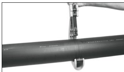
Řez potrubí ruční rotační řezačkou
