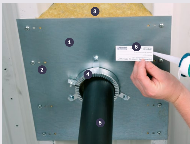
Protipožární set ke vtokům – příklad uložení
