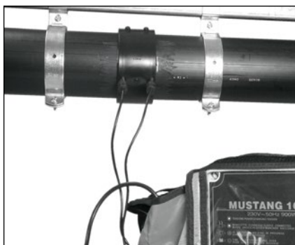
Svařování pomocí elektrodoporového nátrubku
