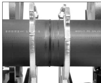
Správně vytvořený svařový spoj natupo
