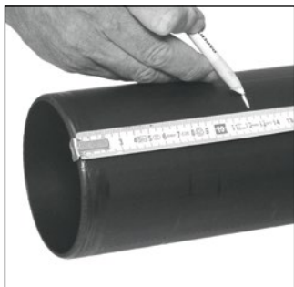
Označení požadované zásuvné délky
