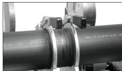
Správně připravené potrubí ke svařování
