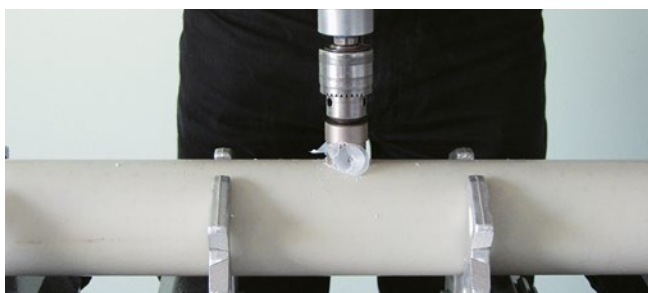
1/ Speciálním vrtákem vyvrtáme otvor pro potrubí.
