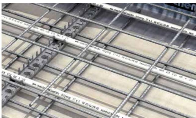
Una volta effettuata la posa del tubo procedere con le verifiche del sistema, il getto del massetto e la prima accensione:
